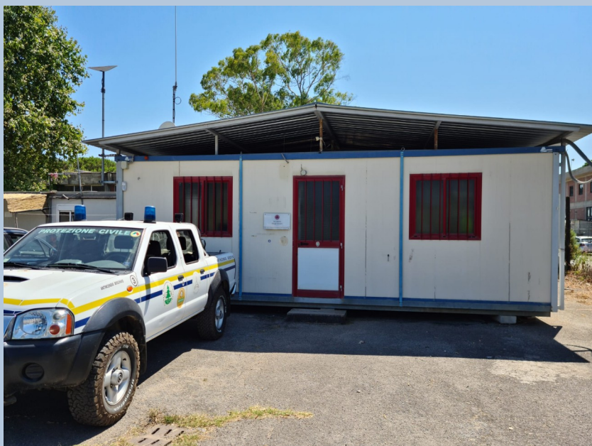
Sala operativa sede COC e Centro intercomunale Monte Pisano
